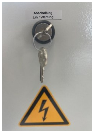
Bild 18 zeigt Wartungs- modus. Schlüssel in Stellung „1“
