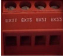
Das andere Kabelende wird wie vorher beschrieben an 24 V DC als Versorgung gelegt. Die Kontakte 4 und 5 des Rauchschalters (der Schaltkontakt NC) werden laut Schaltplan an den Multialert mini auf EX 1 und / oder EX 2 gelegt.
